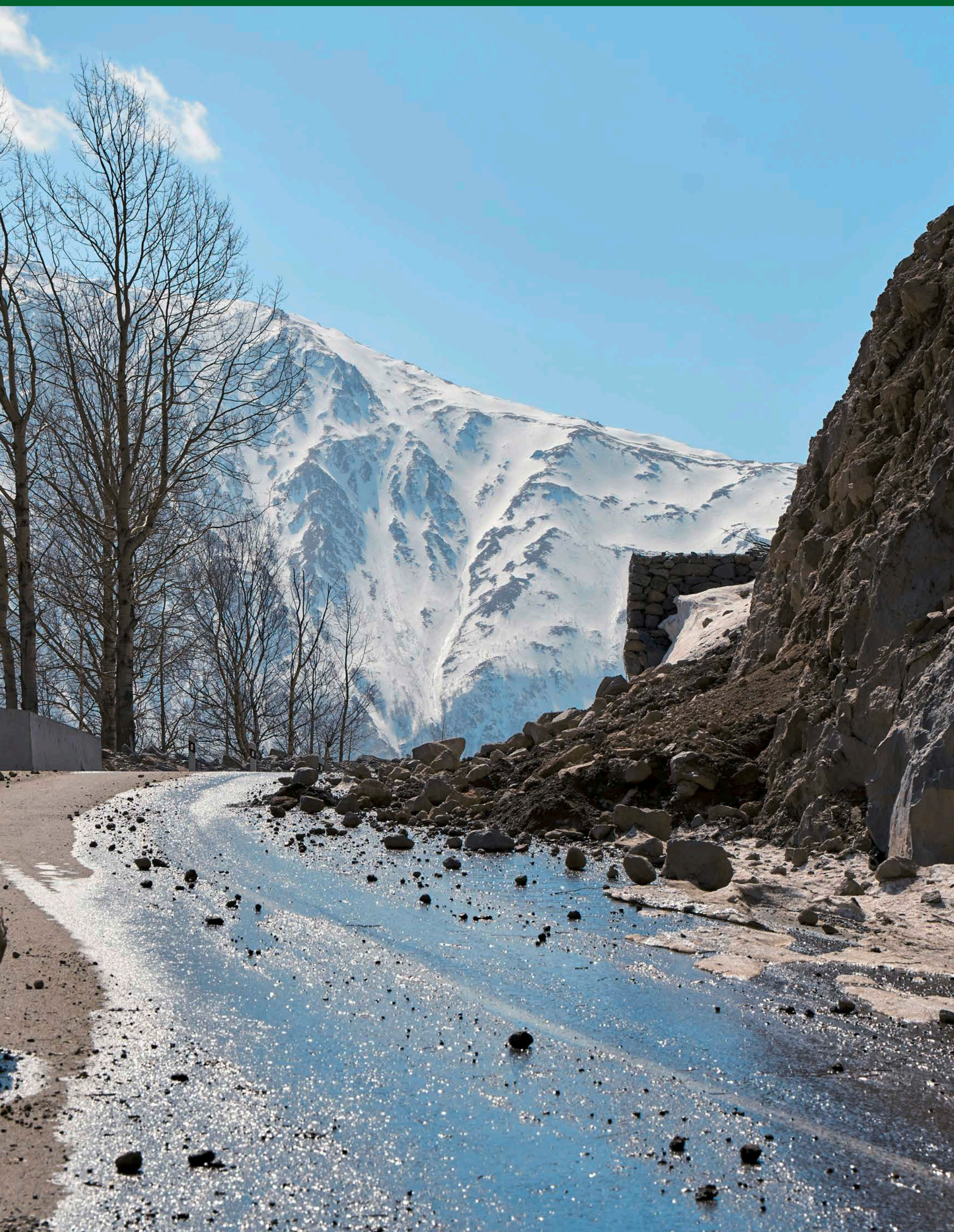
Glissement de terrain
