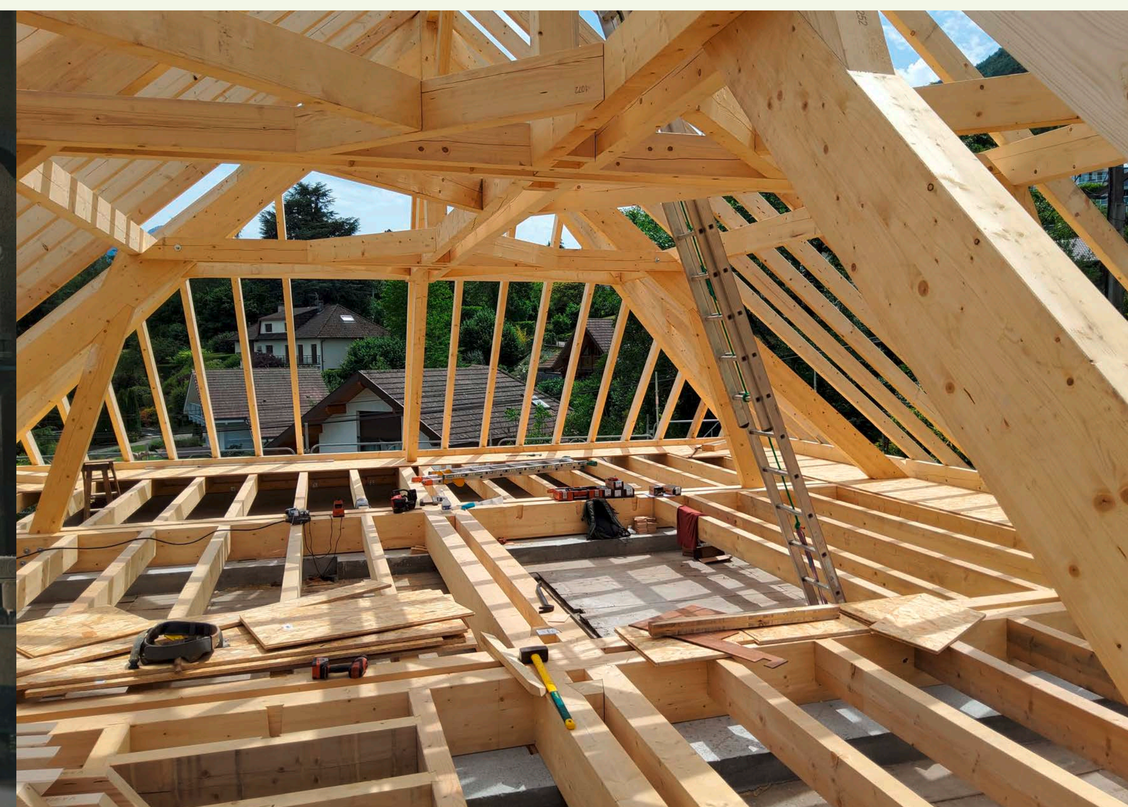
Réalisation d'une charpente
